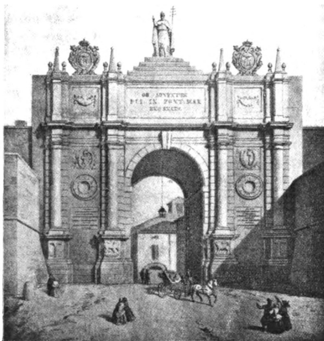
Fig. 409. Porta Adriana in Ravenna restaurata per la visita di Pio IX. (Da una stampa dell'epoca).
